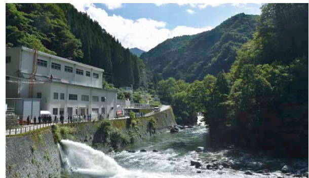
神岡鉱業株式会社 金木戸発電所
